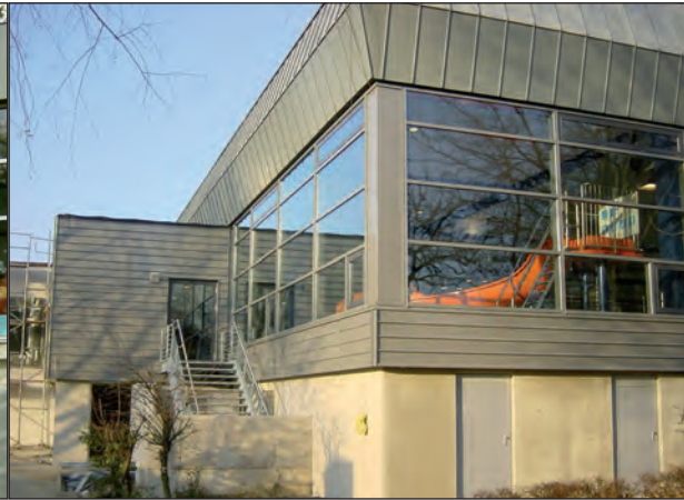
und nach der Erneuerung
