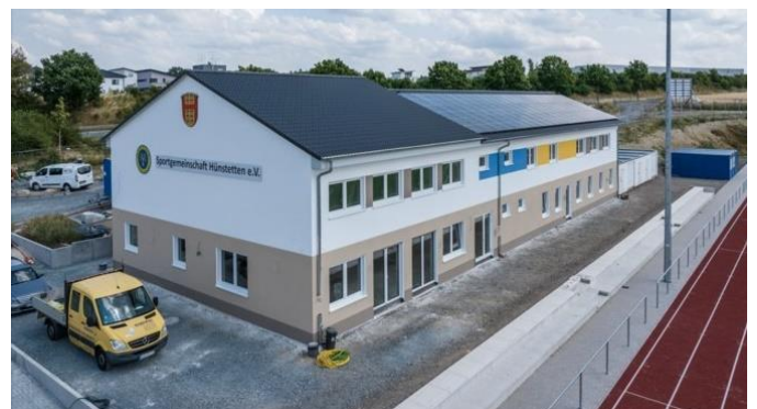
Das klimaneutrale Vereinsheim mit PV-Anlage auf dem Dach. © SG Hünstetten e. V. 1947
